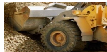
Rekultywacja / Prace ziemne
